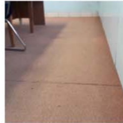
CES Replace flooring
